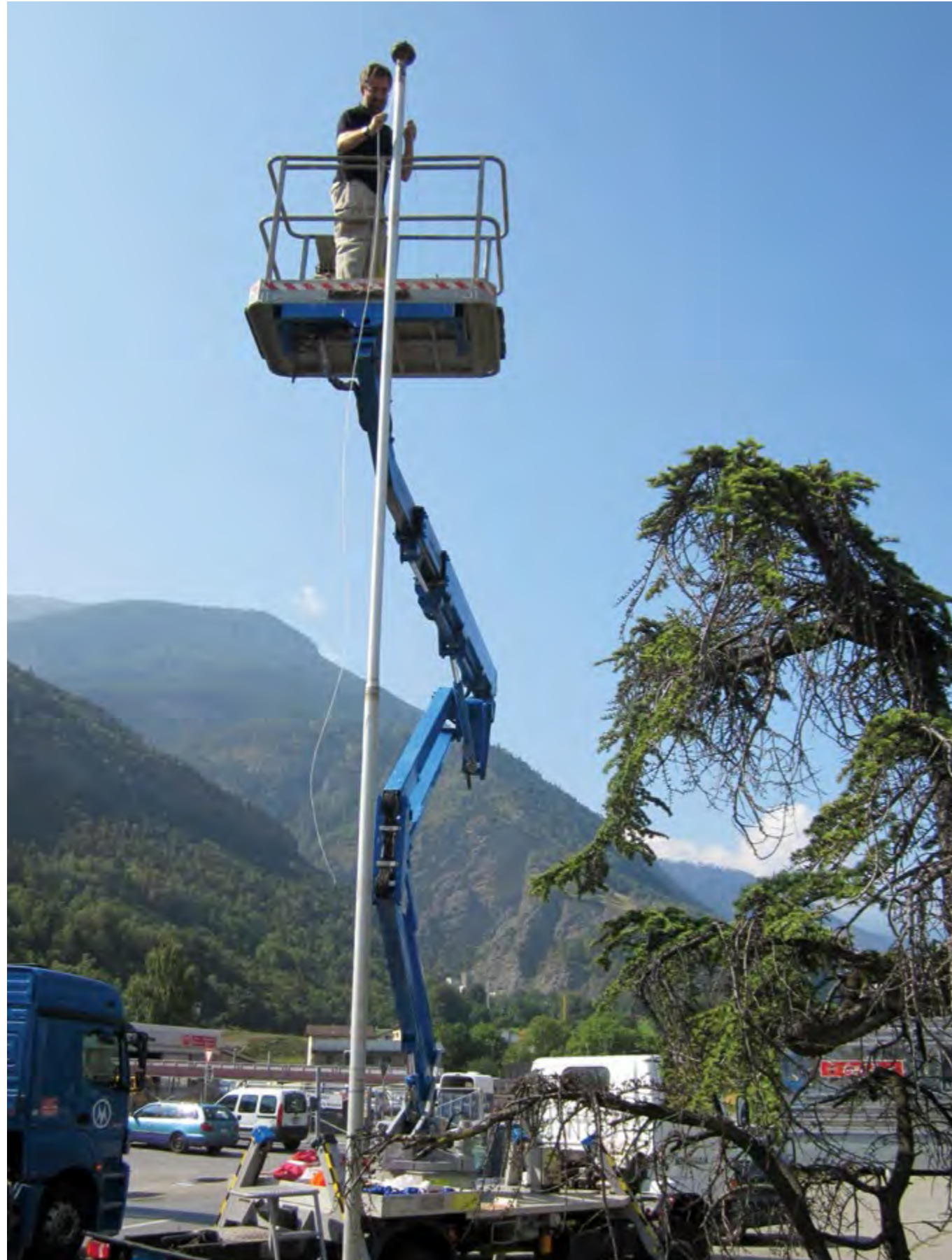
Eigener Lift für Montagen und Reparaturen in luftiger Höhe
