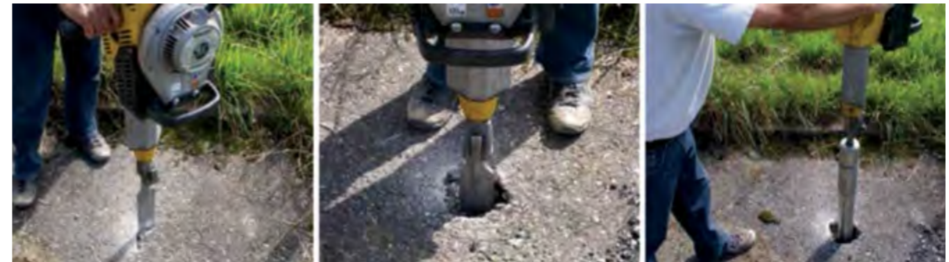
Hülsenkopf auf Asphalt markieren
