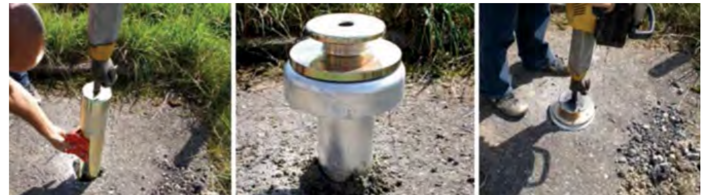
Position mit Wasserwaage überprüfen
